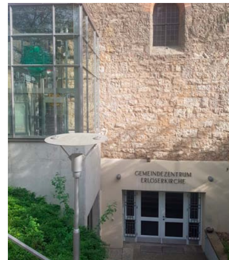
Gemeindezentrum unter der Kirche
